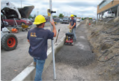
Mise à niveau minutieuse de la fondation supérieure composée de granulats 0-20 mm et compactage
