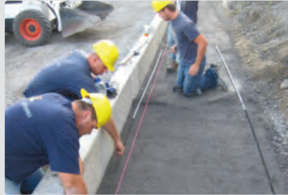
Épandage d'un lit de pose granulaire lâche d'épaisseur maximale de 20 mm
