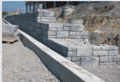
Les bouts de rangs incorporant des retours finis en cascades procurent une excellente stabilité au remblai arrière
