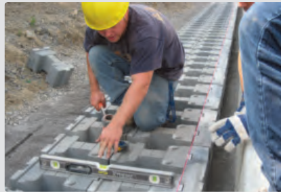
Vérification de l'horizontalité des blocs stabilisateurs posés
